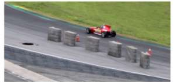
Buraco surgiu do rompimento de uma galeria pluvial dos anos 40.
